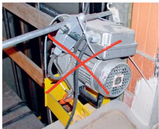
22 Utiliser uniquement des engins de levage prévus pour le transport des personnes!
